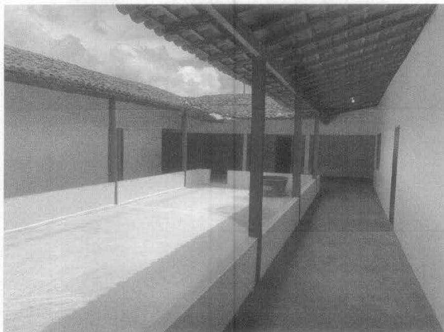
*Imagem 8 – Pintura interna e substituição de pilares de madeira danificado.*
